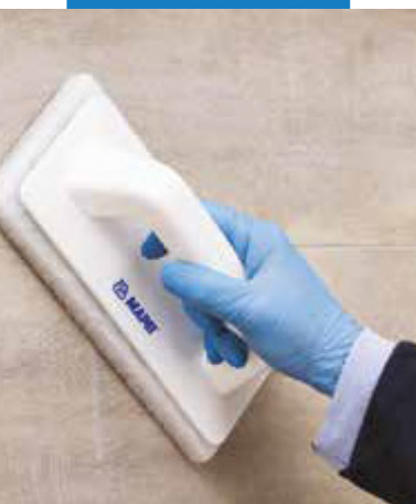
Prvotné čistenie povrchu s čistiacim nástavcom Scotch-Brite®
