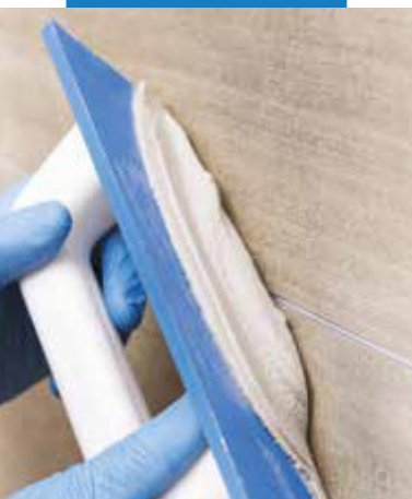
Aplikácia Kerapoxy 4 LVT s použitím gumovej stierky MAPEI
