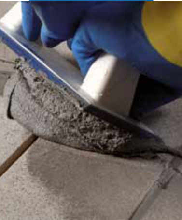
Nanesenie Kerapoxy CQ pomocou stierky MAPEI
