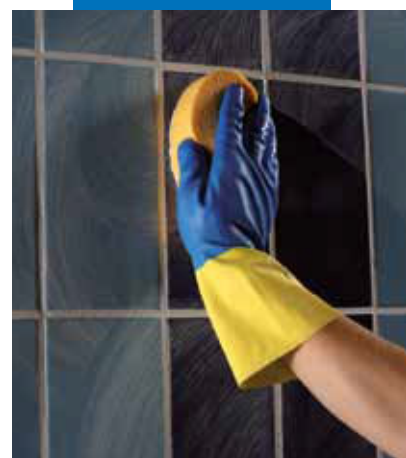
Čistenie a dokončenie povrchu pomocou celulózovej špongie
