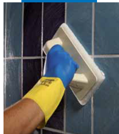
Emulgácia Kerapoxy CQ vodou použitím nástavca Scotch-Brite®
