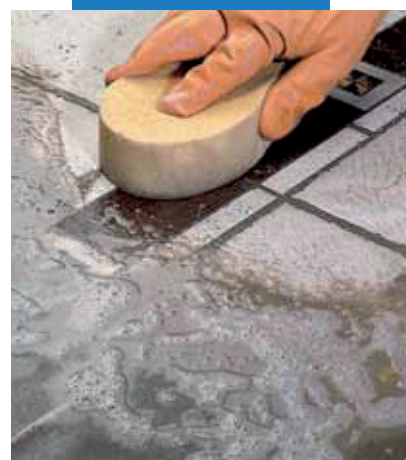
Leštenie keramickej podlahy s drevenými dekormi pomocou špongie
